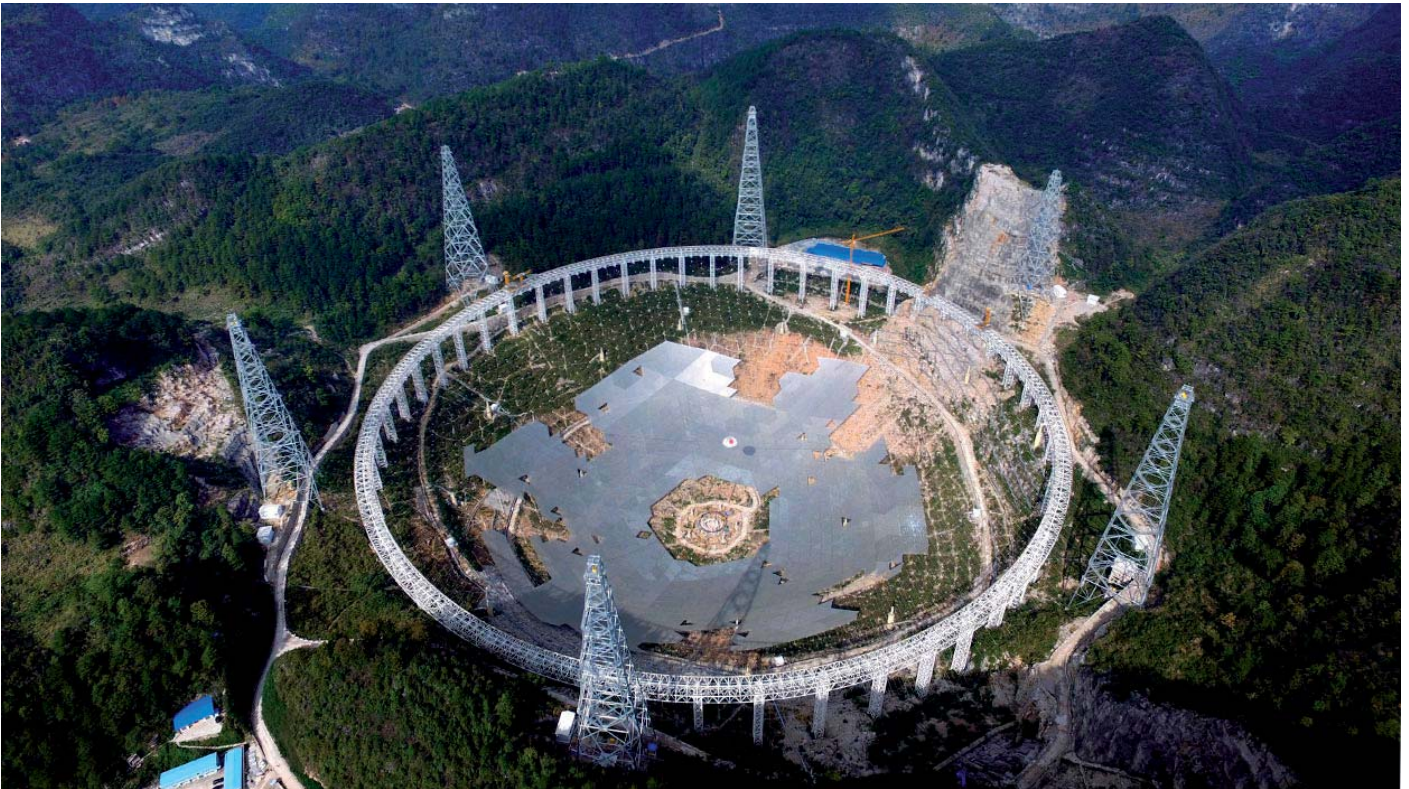
Le Five-hundred-meter Aperture Spherical radio Telescope (FAST) en construction en Chine deviendra le plus grand radio télescope du monde fin 2016. Il fera alors 500m de diamètre et sera trois fois plus sensible qu'Arecibo.
