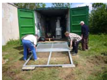
Montage des grilles...
