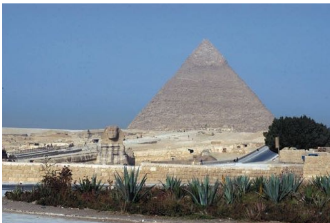
Le Sphinx en cours de rénovation avec la pyramide de Khéphren (IVème dynastie) en arrière plan
